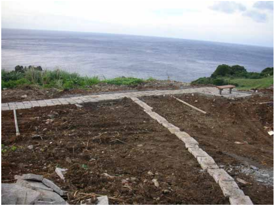
圖 3 照片日期：12 月 1 日（青青草原上正進行水泥步道鋪設）
