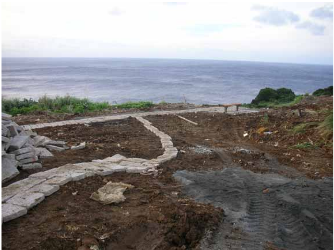
圖 2 照片日期：12 月 1 日 (青青草原上正進行水泥步道鋪設)
