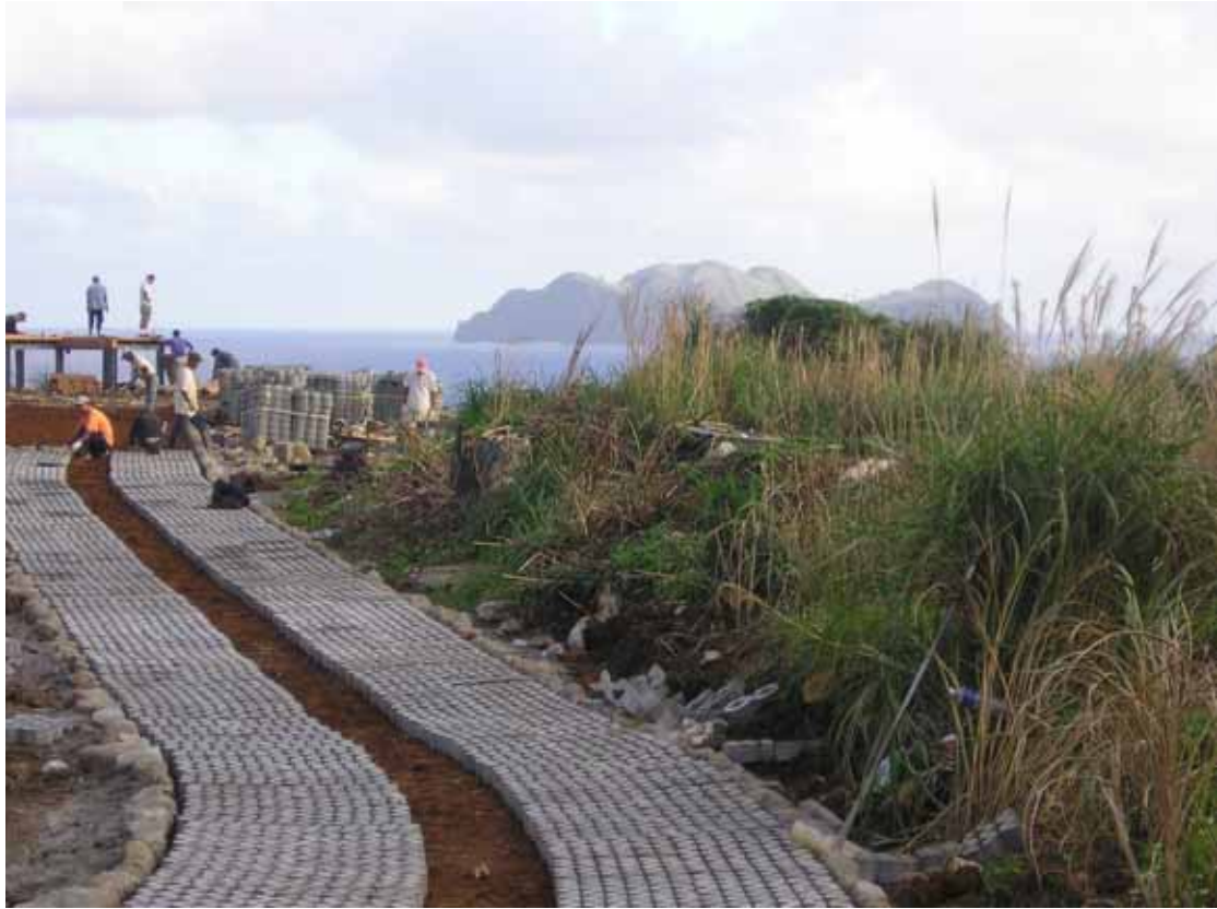
圖 1：相片日期：95 年 11 月 26 日 鋪設聯絡道及觀景台
